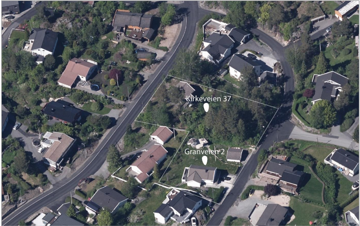
Figur 5 eksisterende situasjon på planområdet.
